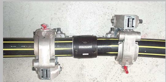
**Manchon libre et coulissant. Soudage et refroidissement suivant prescriptions du fabricant de raccord**
